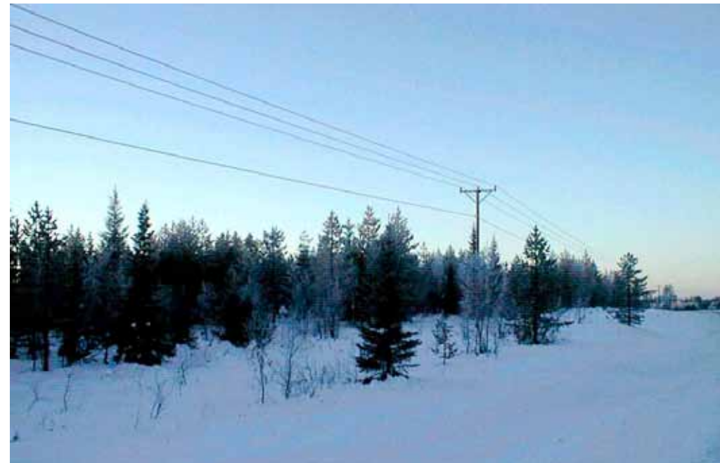
För att slippa svåra grävpassager och minska byggkostnaderna byggdes delar av nätet med svartfiber som hängdes upp i befintliga kraftledningsstolpar.
