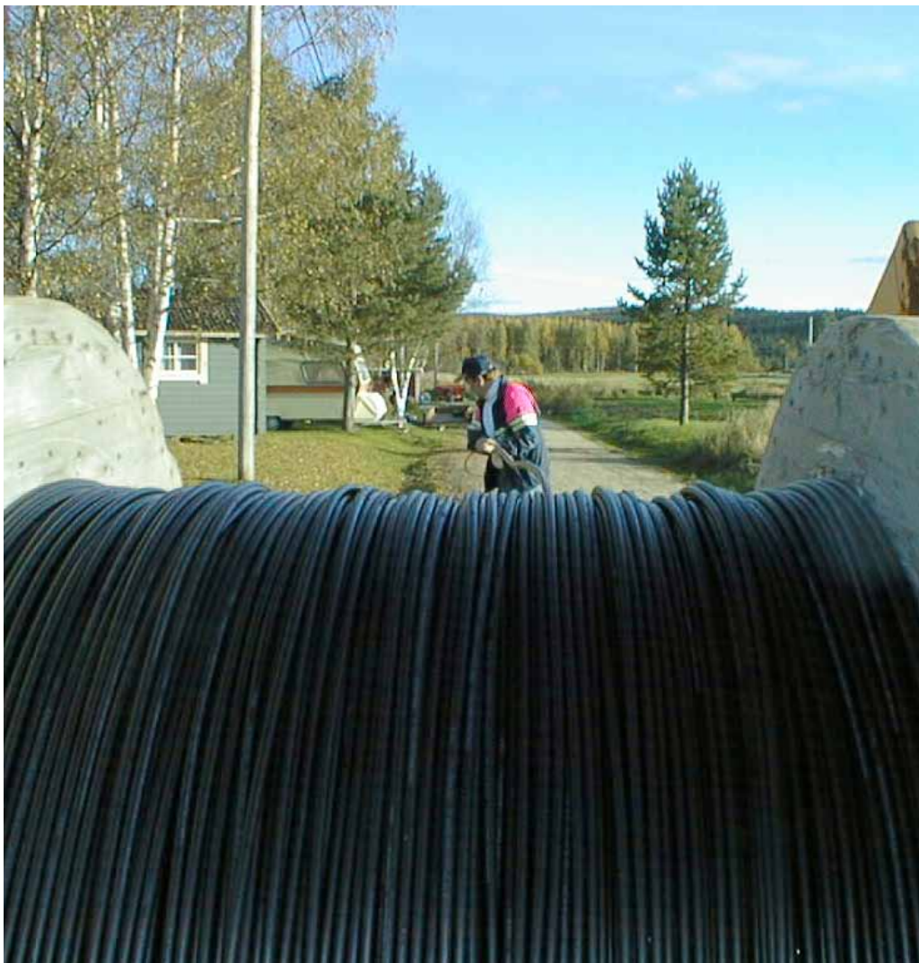
Bykraften var helt avgörande. I vissa byar väntade man inte på pengar utan satte igång att gräva och lägga fiber ändå, alla som kunde hålla i en spade samlades för att hjälpa till.
